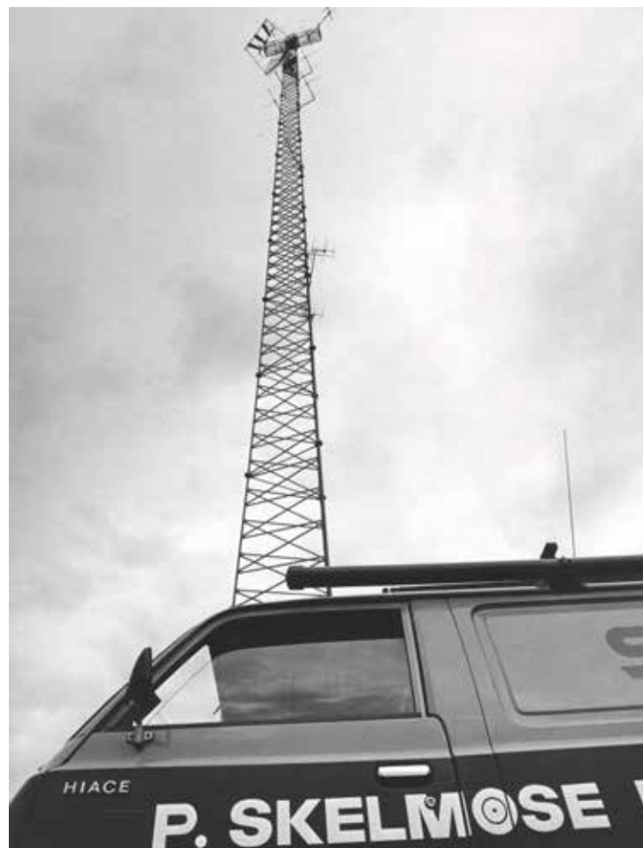
Tekniker Svend Erik Larsen på arbejde ved mast i Varde.
