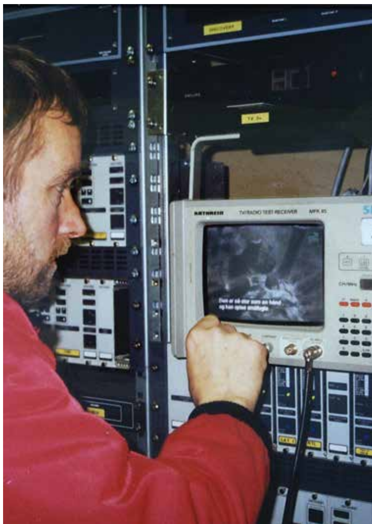
Tekniker tester kvaliteten af de TV-signaler, der bliver hentet ned og vist på TV-skærmene ude hos kunderne.
