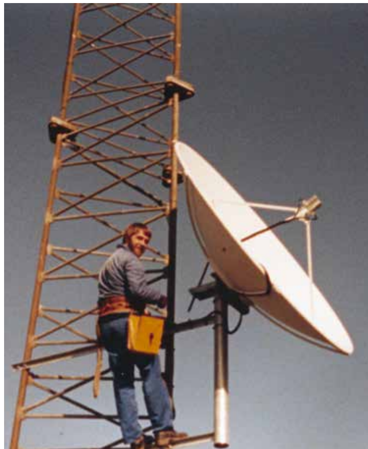
Tekniker Svend Erik Larsen på arbejde på mast i Tarm.
