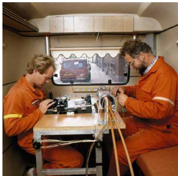
Jydsk Telefon indrettede omkring 1980 en lille campingvogn, så den kunne bruges til at splidse lyslederkabler. I folkemunde blev den kaldt "Smutti".
